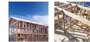
家を支える柱と梁。もっとも大切な構造躯体は、集成材を使用しています。木が持つ本来の特性を考えて適材適所に樹種を選びしっかりとした頑強で強固な構造躯体を作り上げています。
