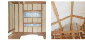
これから永く快適に暮らしていただくために、冬暖かく、夏すずしい、結露や経年劣化に強い、施工欠損が少ない発泡断熱工法を採用しています。さらに天井断熱施工により省エネで快適な住まいとなっています。
