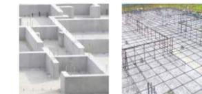
しっかりと地盤調査を行い、基礎全体に十分な鉄筋を配した立ち上がり幅150mmの頑丈基礎。しっかりと組み上げた鉄筋とコンクリートで造る強固で安心なベタ基礎を採用しています。
