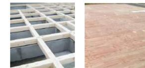
ヒノキ（集成材）で組上げた土台は、強度が強く、耐久性・調湿性・吸湿性に優れた土台です。格子に組み上げた土台は、地震や台風時の水平力によるネジれに強いオリジナル剛床工法を採用しています。
