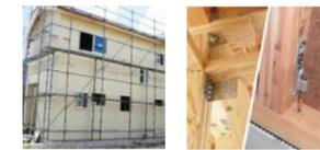
家の壁全体を一体化させる、ゆがみに強いパネル工法を採用。耐火にも優れたパネルを使用することで、耐震性と耐火性に優れた建物になります。また、軸組みの接合部強度をより高めるために、基礎から土台、柱、梁に至るまで専用の耐震金物で強度を高めています。
