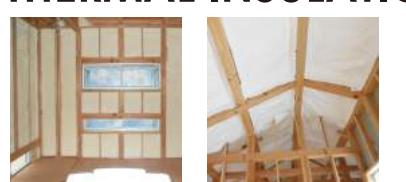
これから永く快適に暮らしていただくために、冬暖かく、夏涼しい、結露や経年劣化に強い、施工次第少しがんばり断熱工法を採用しています。さらに天井遮熱施工により省エネで快適な住まいとなっています。
