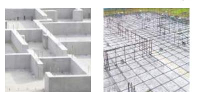
地盤調査を行い、基礎全体に十分な筋鉄を配した立ち上がり幅 150mm の頑丈基礎。しっかりと組み上げた鉄筋とコンクリートで造る強固で安心なバタ基礎を採用しています。
