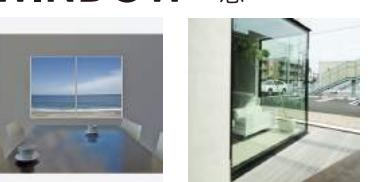
サッシのフレームを極小化しデザインと断熱性能に優れた窓を採用。さらに、遮熱・高断熱タイプで、紫外線をカットしてくれる Low-E ベーガラスにより、快適な室内環境を実現しています。
