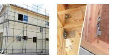
家の壁全体を一体化させる、ゆがみに強いパネル工法を採用。耐火にも優れたパネルを使用することで、耐震性と耐火性に優れた建物になります。また、軸組みの接合部強度をより高めるために、基礎から土台、柱、梁に至るまで専用の耐震金物で強度を高めています。
