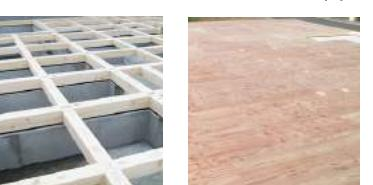
ヒノキ（集成材）で組み上げた土台は、強度が強く、耐久性・調湿性・吸湿性に優れた土台です。格子に組み上げた土台は、地震や台風時の水平力によるねじれに強いオリジナル剛床工法を採用しています。
