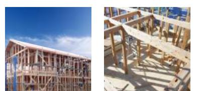
家を支える柱と梁。もっとも大切な構造躯体は、集成材を使用しています。木が持つ本来の特性を考えて適材適所に樹種を選び頑強で強固な構造躯体を作り上げています。
